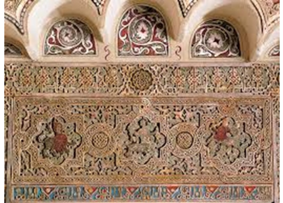
PALACIO –CONVENTO DE SANTA CLARA TORDESILLAS. VESTÍBULO
