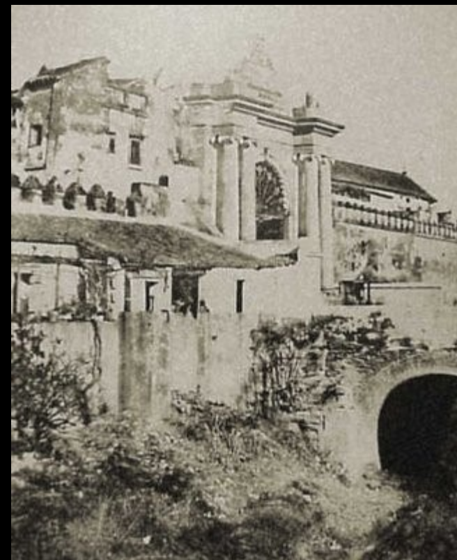
Puerta de Jerez y arroyo Tagarete desviado de su cauce en 1849
