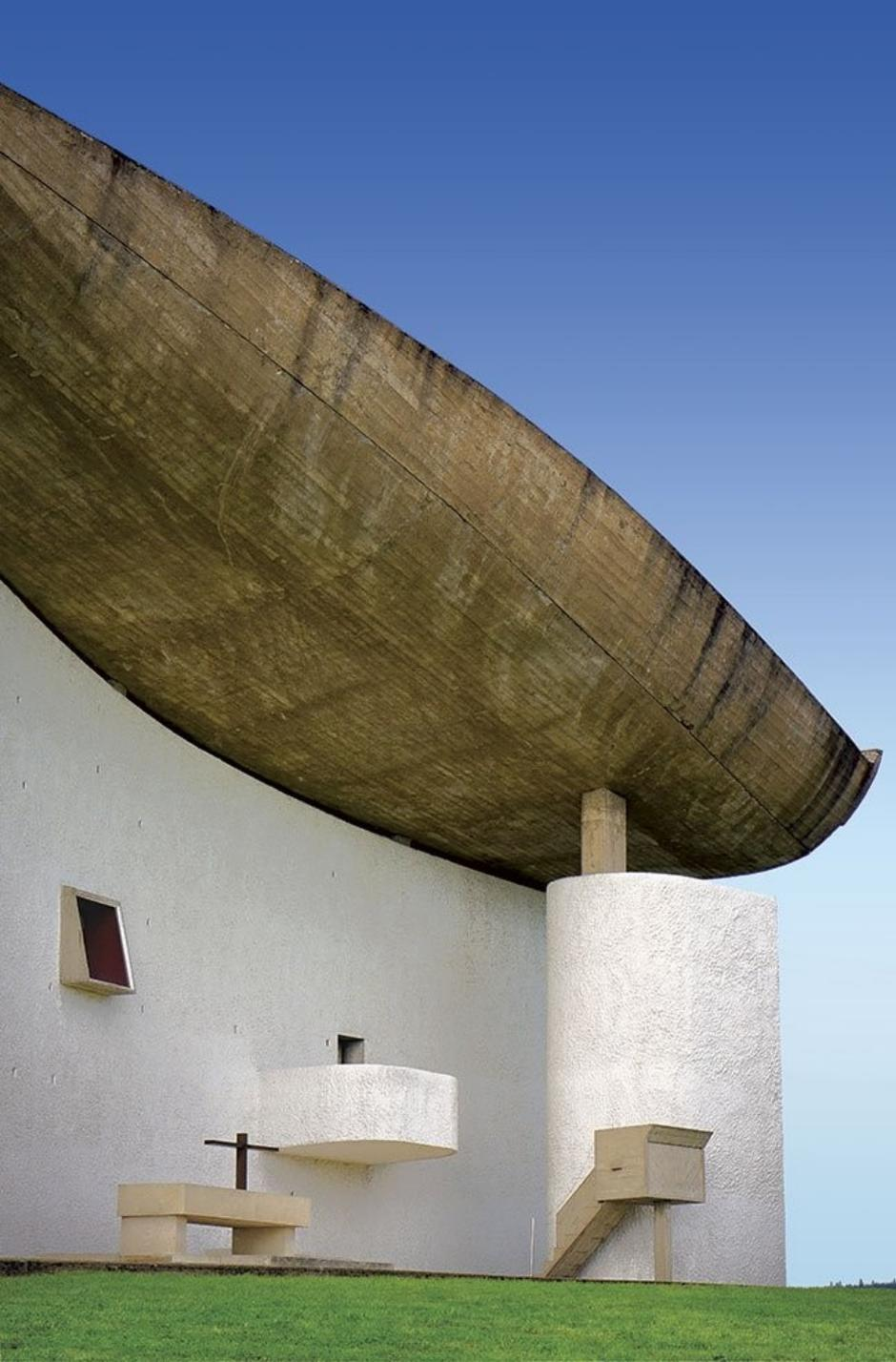
Para la cubierta de hormigón armado Le Corbusier se inspiró en el caparazón de un cangrejo, uno de sus “objetos de reacción poética”.
