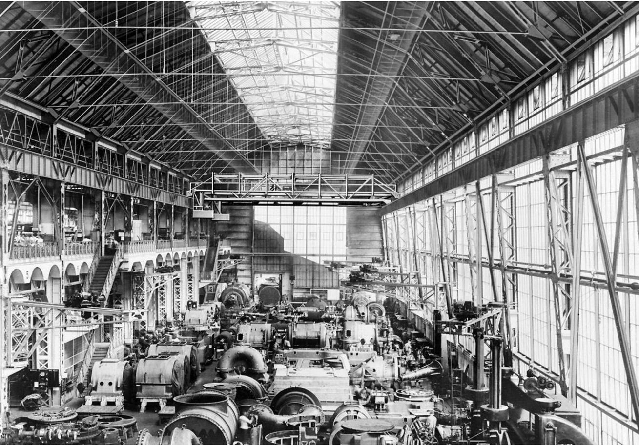
La fábrica de turbinas AEG. El edificio original mide 123 m de largo, 25 m de alto y 25 m de ancho. Construido completamente con materiales modernos- hierro, hormigón y vidrio-.
