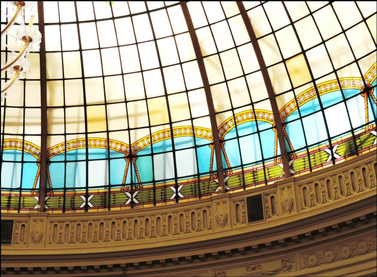
La cubierta de este gran salón circular, alrededor del cual se distribuyen los servicios principales del hotel, consta de una cúpula acristalada apoyada sobre columnas pareadas, que coincide con el patio interior alrededor del cual se distribuye el edificio. La gran vidriera se sujeta con una estructura de hierro sobre la que descansan las pletinas que forman los numerosos paneles.
