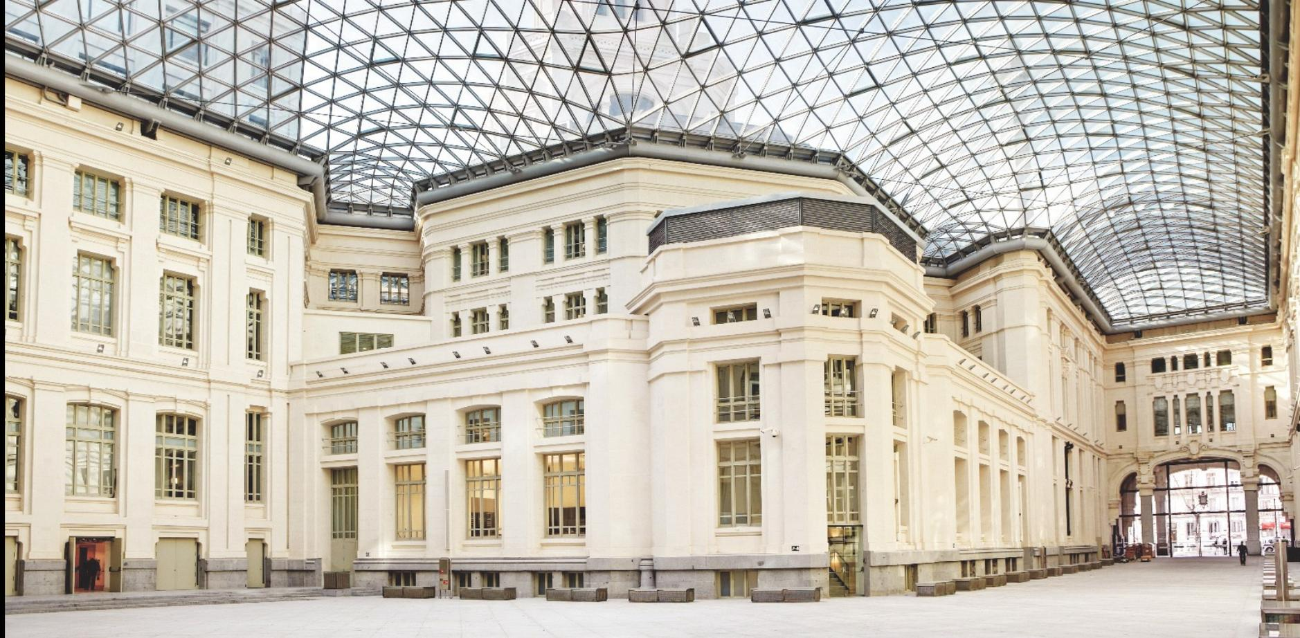
**PALACIO DE COMUNICACIONES (Patio de Alarcón) DESPUES DE LA ÚLTIMA REFORMA,** Patio interior, patio de Cristales con la bóveda diseñada por Pernas a la manera de una trama de un colador, elevada a 23 metros de altura de acero y triángulos de vidrio.
