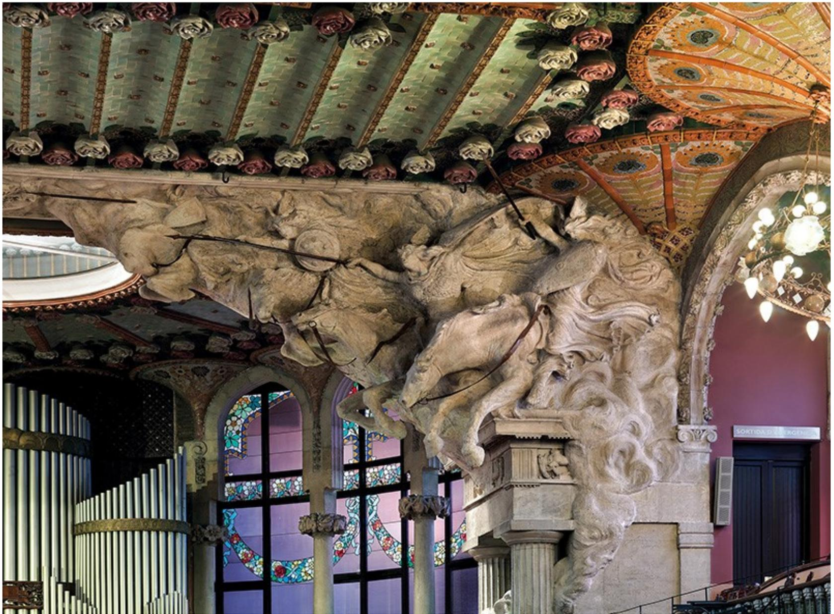
Piedra de Vilafranca y morteros de cal, y que cuenta en su interior con elementos metálicos conformando la estructura.
